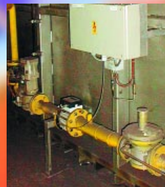
USM in der Regler-eingangsstrecke vor dem Ofen
