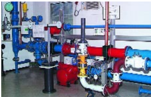
Abb. 2: Basiskalibrierung TRZ G 160 DN 80 bei ungestörter Anströmung
