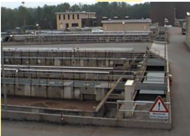
Kläerbecken mit Speichertürmen im Hintergrund
