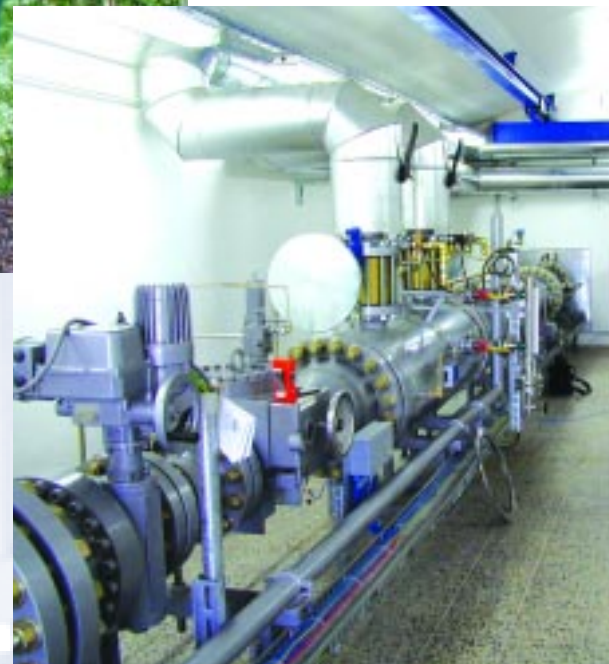
Aufbau der mess- und regelungstechnischen Komponenten einer Schiene
