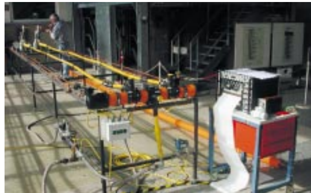
Abb. 1: Hausinstallations-Prüfstand, Ruhrgas AG, Dorsten
