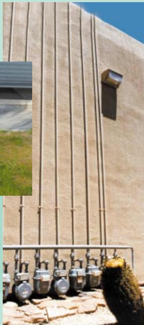
Lange Leitung – entdeckt in Sedona, Arizona USA, von P. Lambers
