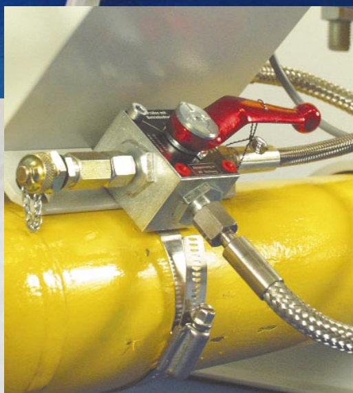
Abb. 1: Horizontale Montage des EK260 auf eine Rohrleitung
