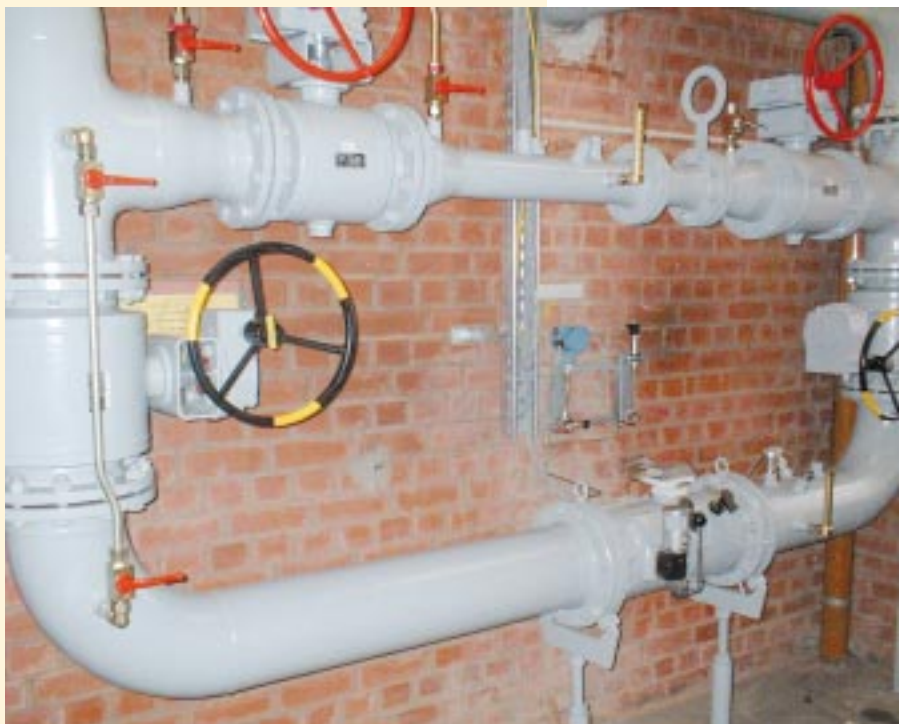
Abb. 1: Turbinenradgaszähler G1000 DN200 PN16 mit Encoder-Zählwerk und zwei HF-Impulsgebern
