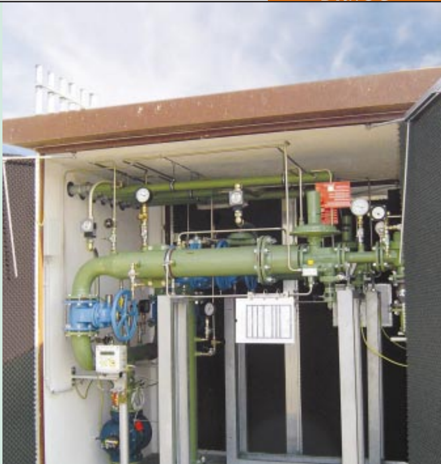
Abb. oben: Gasstation mit EK260 ohne externe Stromversorgung
