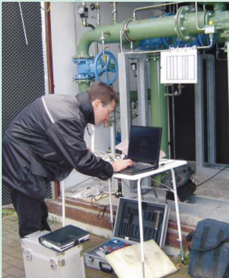
ELSTER-Kundendiensttechniker Jörg Spotke bei der Parametrierung des Mengenumwerters
