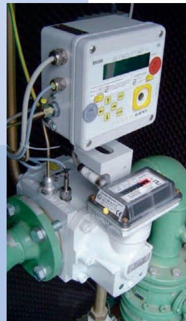
ELSTER-RVG mit ENCODER C1 und Mengenumwerter EK260
