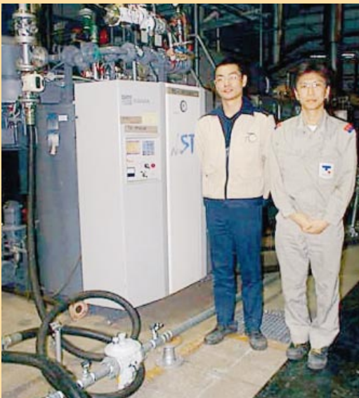
Prüfstand bei einem großen Gasversorgungsunternehmen
