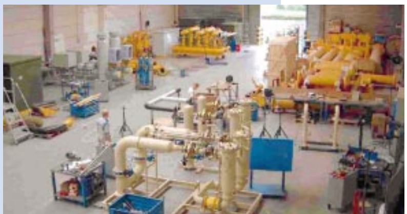
Montage spezieller Großprojekte
