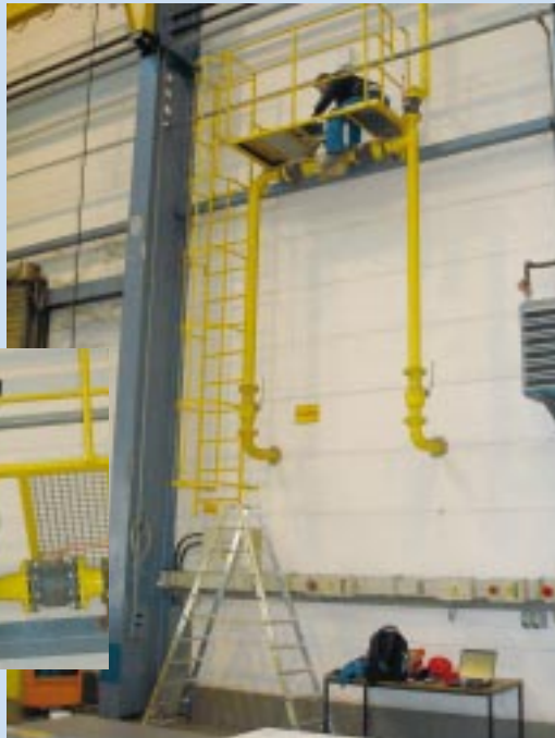
Abb. 1: EK260 Installation auf einer Rohrbrücke
