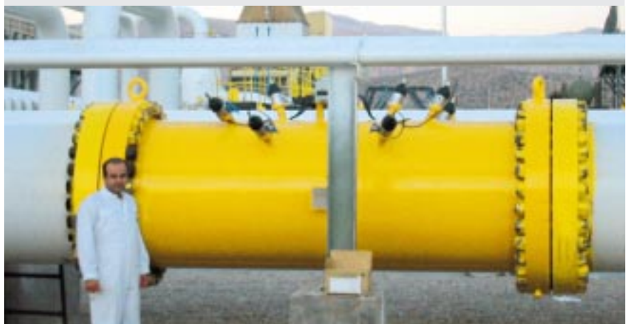
Ultraschallgaszähler 48" ANSI 600 im Betrieb im Iran
