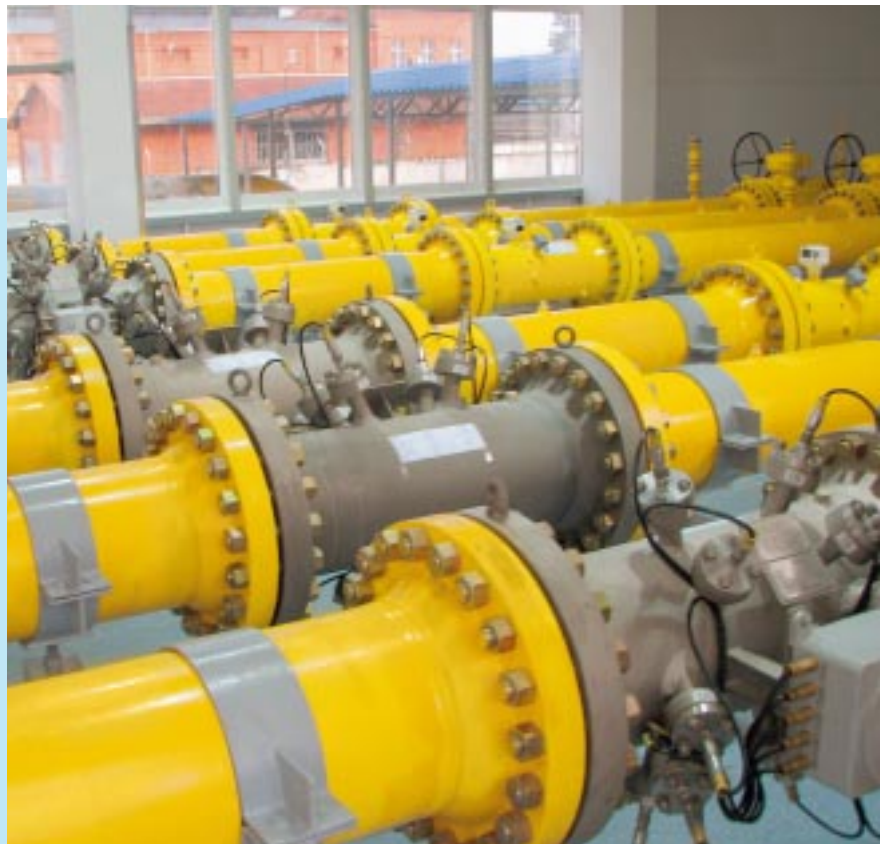
Abb. 4: Sekundärnormal mit Ultraschallzählern als Prüfnormale
