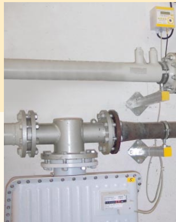
DL210 am BK-G65 mit Absolut-ENCODER, Spannungsversorgung durch CEE-Steckverbindung
