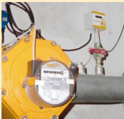
DL210 am IRM mit Absolut-ENCODER-Zählwerk
