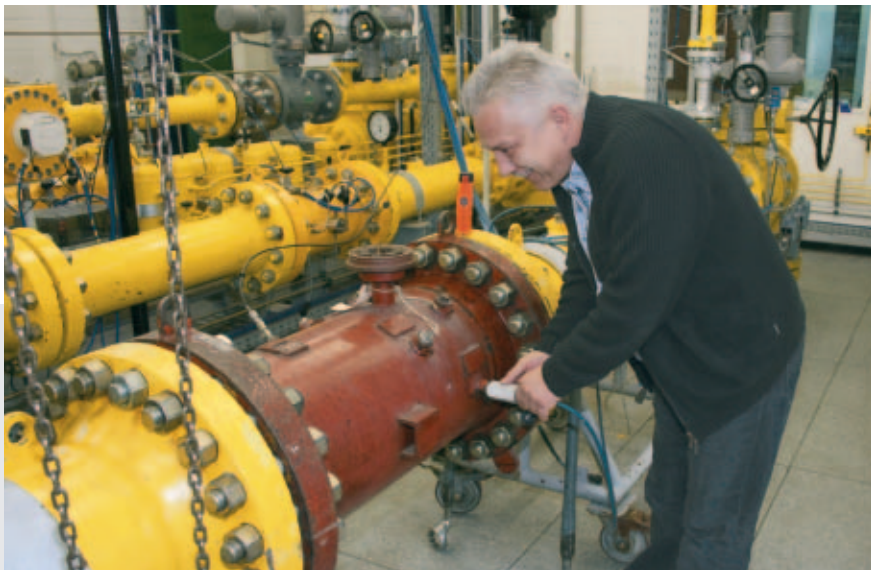
Ulrich Müller kontrolliert die Impulsübertragung einer Messpatronenprüfung
