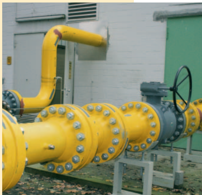
Aus DN200- wurden DN250-Rohrstrecken
