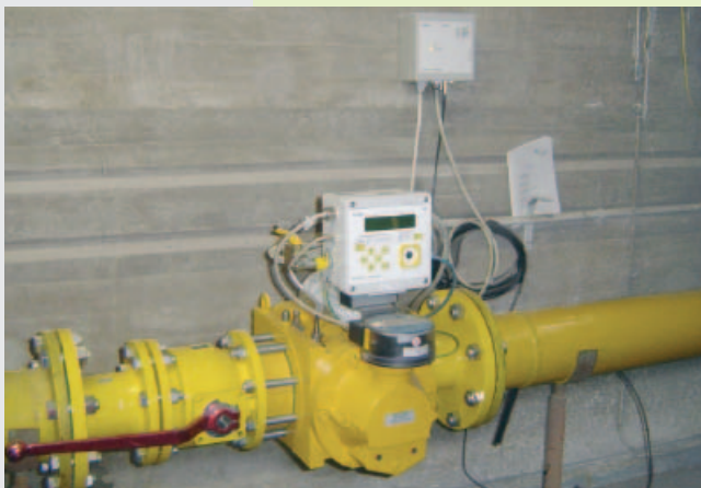
Neue Messstrecke Krankenhaus
