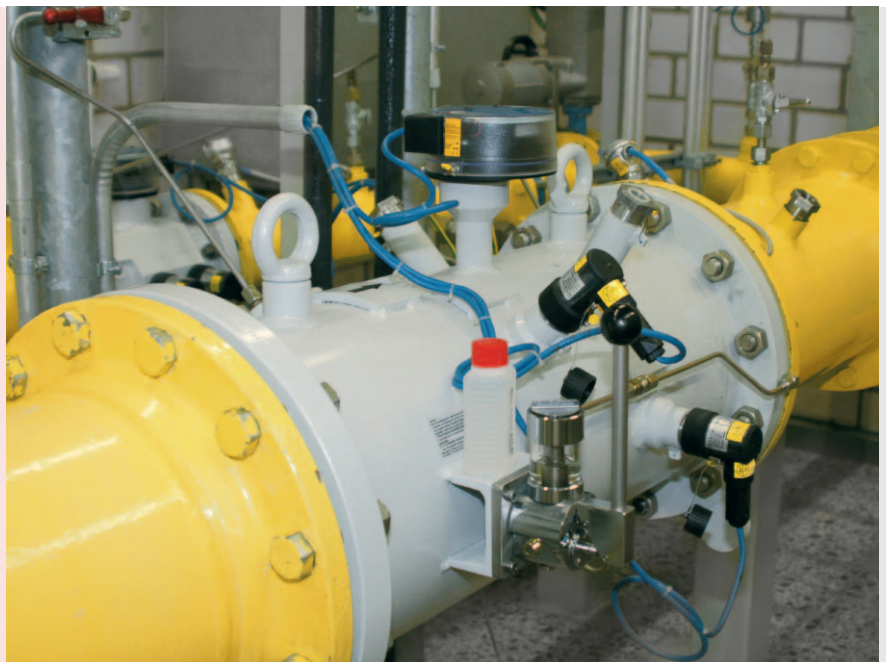
E.ON-Gasübernahmestation: TRZ 2 mit umgebautem Encoder-Zählwerkskopf und neuer Schaltschrank- bestückung
