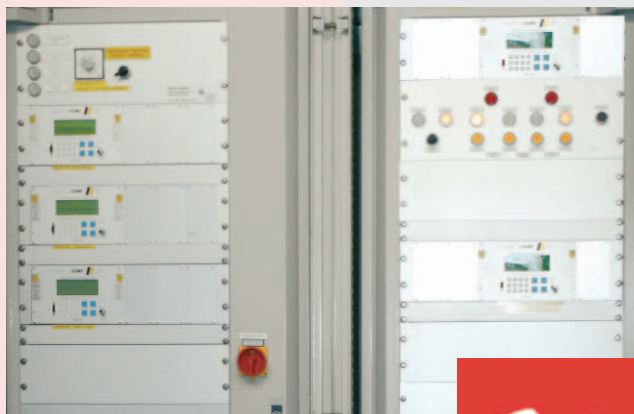
E.ON-Gasübernahmestation: TRZ 2 mit umgebautem Encoder-Zählwerkskopf und neuer Schaltschrank- bestückung
