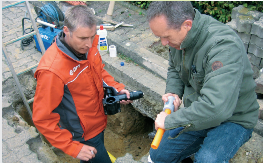
Torsten Lotze (E.ON Avacon) und Torsten Hain (HTI Collin) bei der Montage der Permasert-Verbindungselemente
