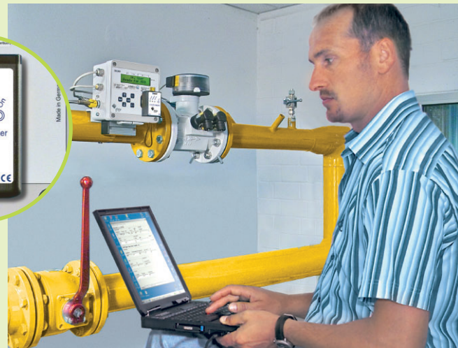
Abb. 1: Drahtlose Verbindung zum Laptop mittels Bluetooth LIS-200 Adapter am EK260
