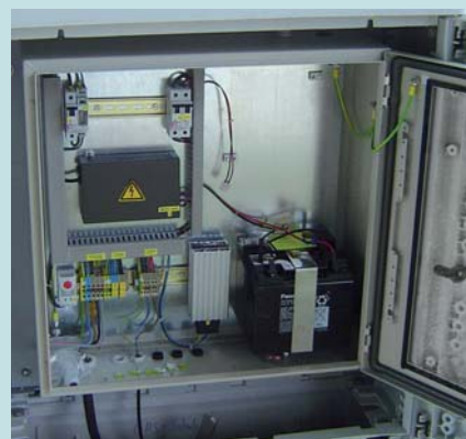
Abb. 2 und 3: Separater Schaltschrank mit Akku, Laderegler und Frostwächter zur Energieversorgung von Modem und Mengenumwerter
