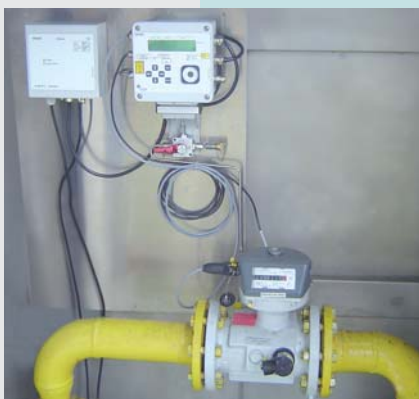
Abb. 2 und 3: Separater Schaltschrank mit Akku, Laderegler und Frostwächter zur Energieversorgung von Modem und Mengenumwerter
