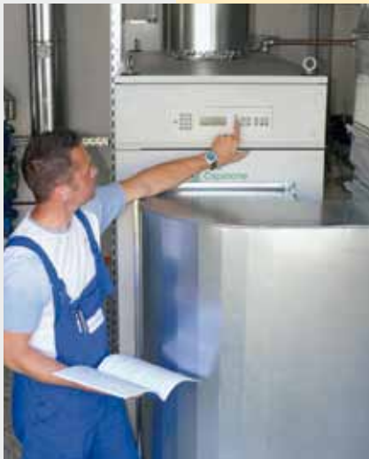
Mikrogasturbine in der GDRM-Anlage
