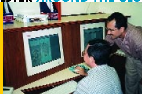
Fig. 4 : Ing. Robert Cure, Sub-Gerente Técnico and Ing. Miguel Cepeda, Jefe Departamento Técnico y Operaciones discuss network operations data at one of the Pantheon consoles in the Gas Control Room at Gases del Caribe, Barranquilla Ing. Robert Cure, Sub-Gerente Técnico e Ing. Miguel Cepeda, Jefe Departamento Técnico y Operaciones, revisando datos de operación de la red en una de las consolas Pantheon en la Sala de Control de Gas de Gases del Caribe, de Barranquilla
