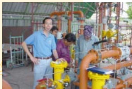
KC Tan (Engineering Mgr.) inspects the skids
