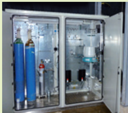
Biogas production plant Kielen, Luxembourg
